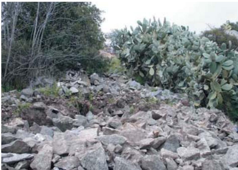
Fig. 55. La discarica di Fonte del Prete (2007)
